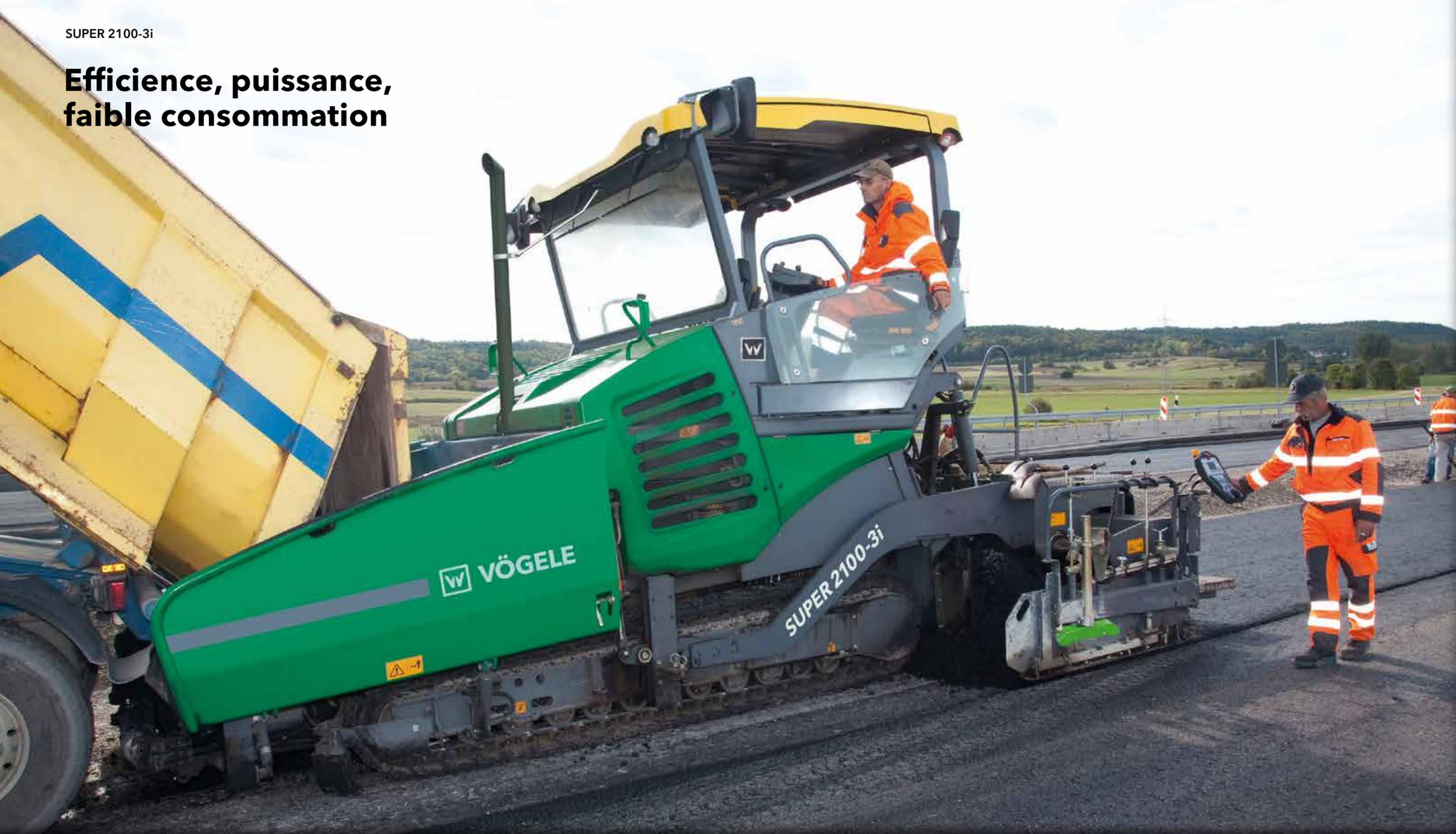
**La force motrice** du finisseur Highway Class est son puissant moteur diesel six cylindres de 186 kW.
